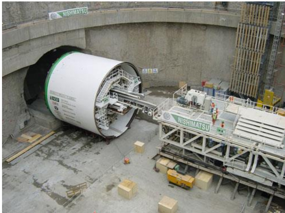
Figur 103, Eksempel på opstilling af TBM i startkammer (Dublin Port Tunnel).
