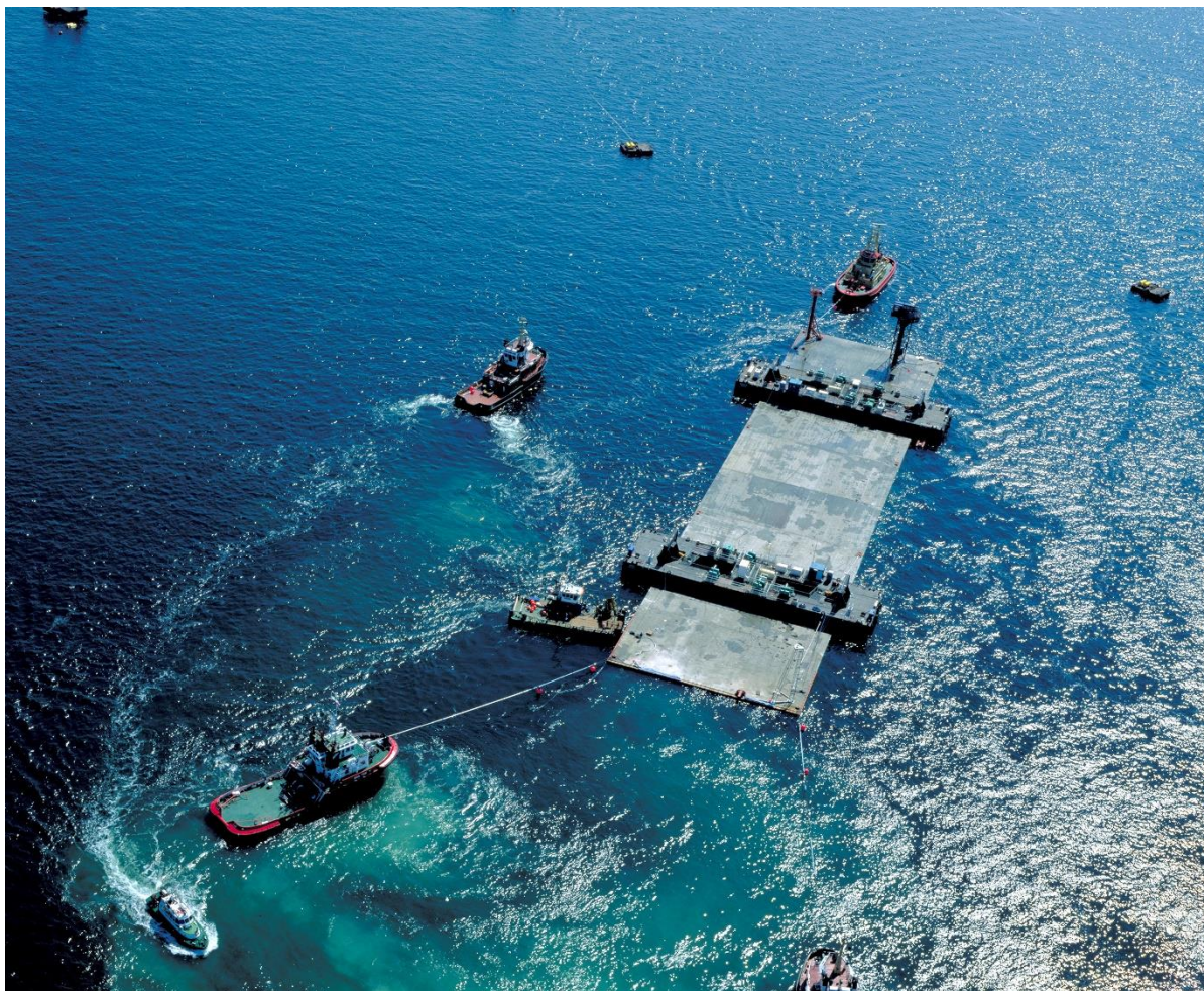
Figur 7-38 Eksempel på transport af sænketunnelelement (Øresund).
