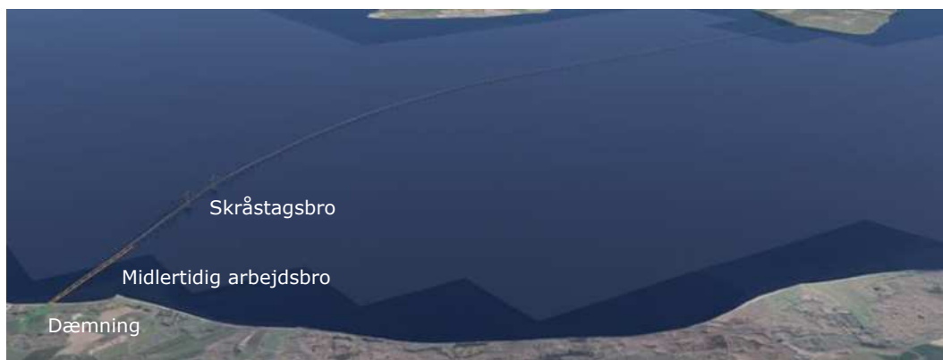
Figur 17-4 Visualisering af ALA07 Bro (med gennemsejlingsfag bestående af en skråstagsbro).
