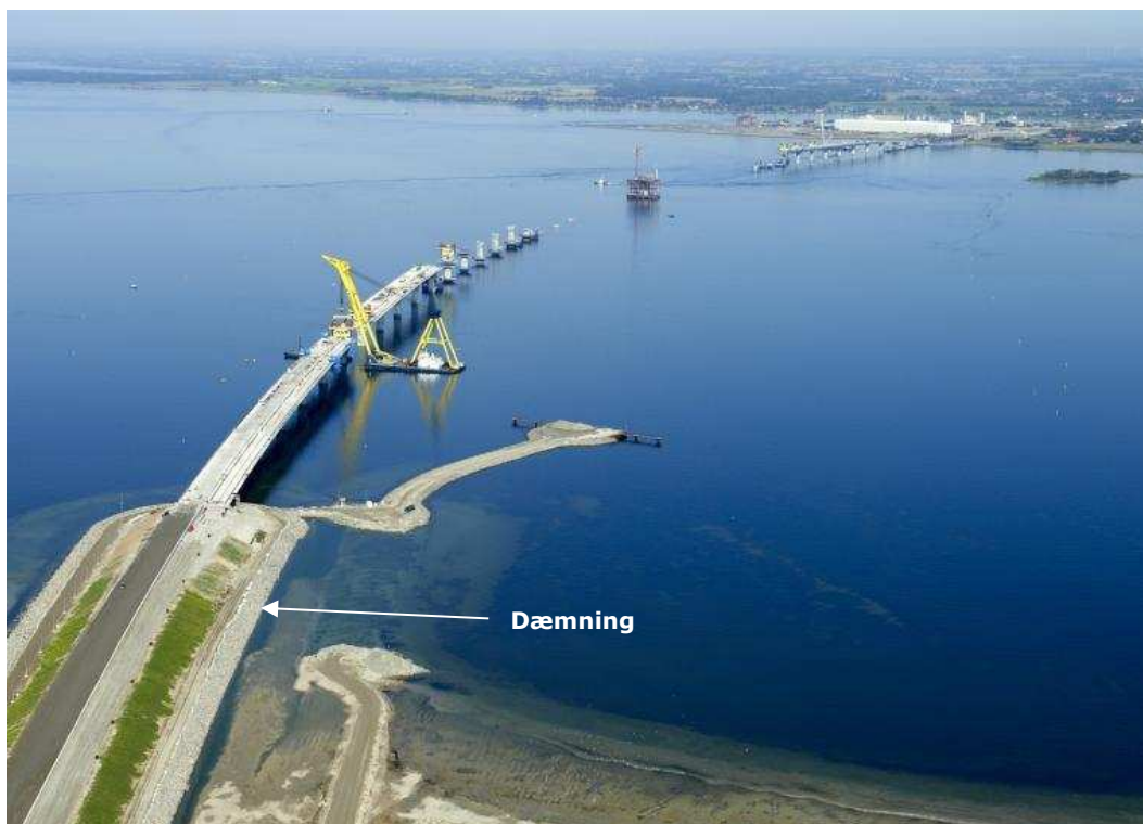
Figur 5-16 Eksempel fra Storstrømsbroen. Permanent dæmning ved Falster.
