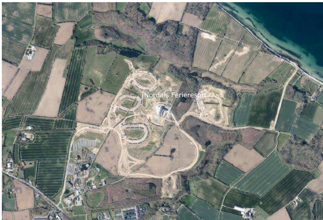
Figur 6-4 Ortofoto som viser det påbegyndte byggeri af Nordals Ferieresort. /193/
