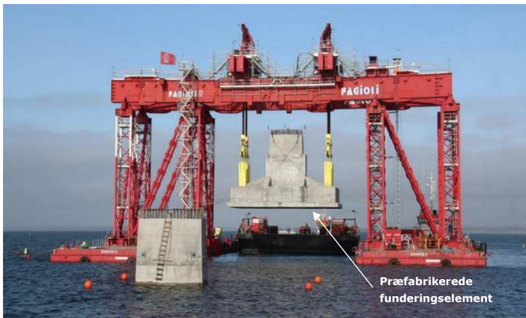
Figur 5-10 Præfabrikeret fundament sænkes ned på havbunden til ny Storstrømsbro.
