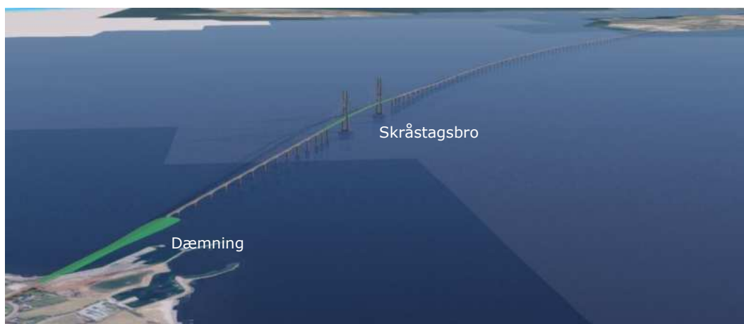
Figur 13-5 Visualisering af ALA02 Bro (med gennemsejlingsfag bestående af en skråstagsbro).
