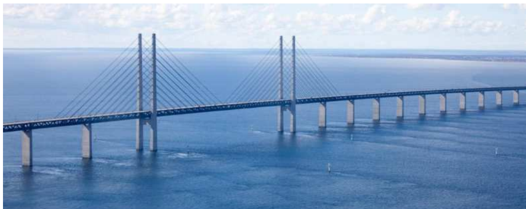
Figur 5-8 Øresundsbroen er en bjælkebro – med en skrånstagsbro som gennemsejlingsfag.
