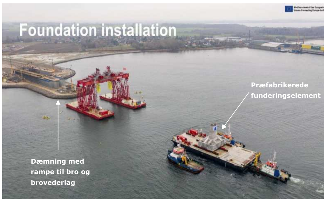
Figur 5-9 Præfabrikerede fundamenter flådes på plads (fra Storstrømsbroen).
