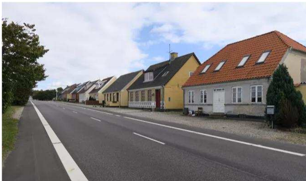
Figur 9-29. Billede fra den udpegede særligt bevaringsværdige landsby i Bøjden. Ved Bøjdenlandevej ligger lave boligbebyggelser med smalle forhaver.
