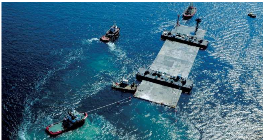
Figur 5-14 Eksempel på transport af sænketunnelelement (Øresundsbroen/tunnelen).
